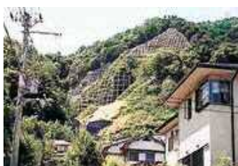
工事完了直後
