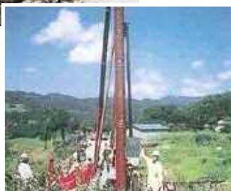
杭工(新温泉町飯野地区)
