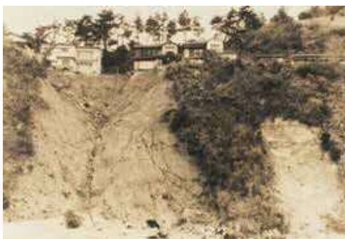
がけ崩れによる被害状況 (神戸市長田区明泉寺町)
