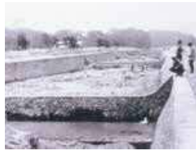
流路施工後の 昭和初期の逆瀬川
