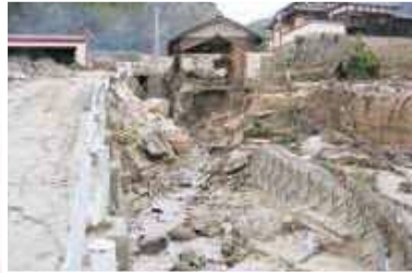
上流から土石流が越水しはん濫(洲本市五色町)
