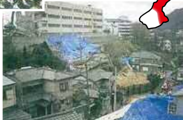
がけ崩れによる被害状況 (神戸市長田区大丸町)
